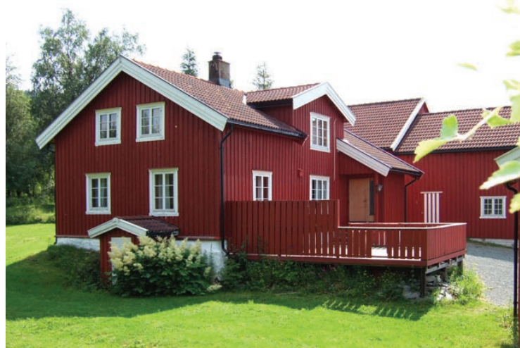
Tømmerholt en sommerdag i august. Nytt rekkverk på plattformen er kommet på plass etter at bildet ble tatt.
